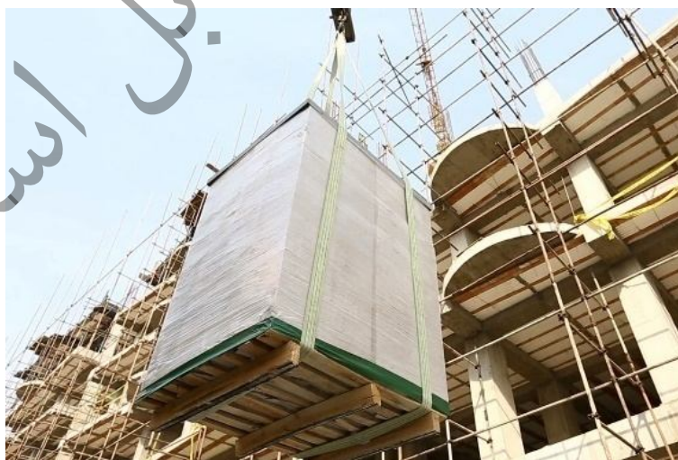
شکل ۱۰-۱- انتقال پالت‌های بلوک‌های AAC در کارگاه
