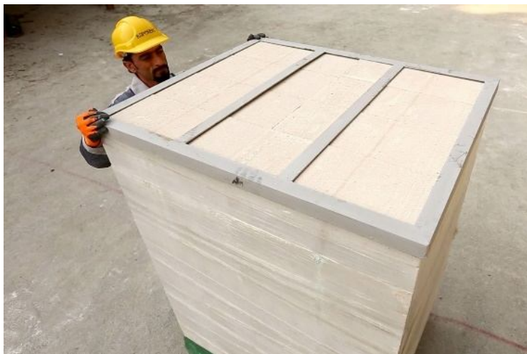
شکل ۹-۱- حمل پالت‌های انتقال بلوک‌های AAC
